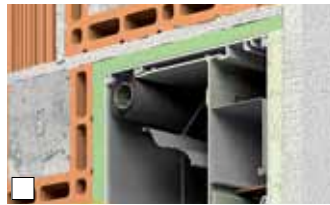
Das integrierte Insektenschutzgitter* hält Plagegeister draussen.
